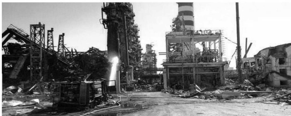
Рис. 1. Состояние Ачинского НПЗ после пожара [1].
